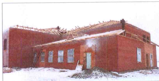
■ Активно ведётся строительство детского сада в деревне Камышево. Жители с гордостью заявляют, что это первый в истории деревни настоящий детский сад. Раньше дошкольные учреждения размещались в приспособленных помещениях.
